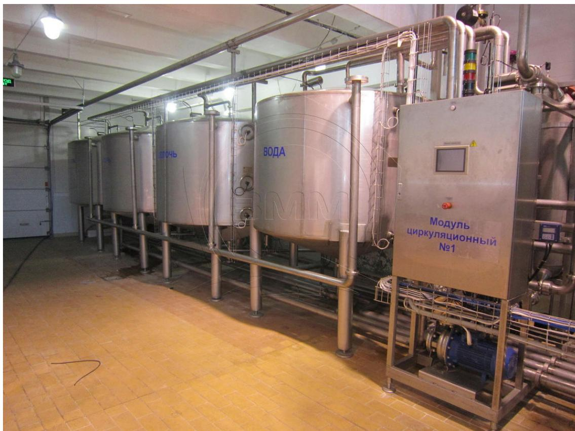
Универсальная циркуляционная моечная станция двухконтурная УЦМС-2К
